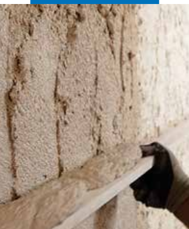
Staggiatura di Mape-Antique Eco Risana
