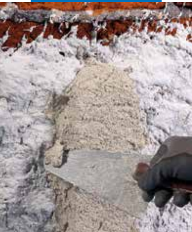
Realizzazione di una fascia con Mape-Antique Eco Risana
