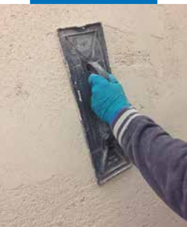
Ripianatura di Mape-Antique Eco Risana
